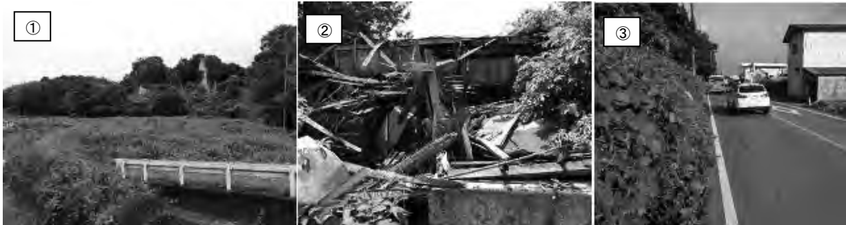
写真2 景観を損ねる廃屋・草木の繁茂(①7月7日、②5月25日、③8月14日撮影)
